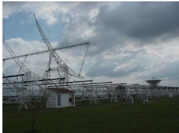
La coppia di strumenti esplora ciascuno il suo emisfero celeste. La superficie delle antenne non è continua, ma formata da fili di acciaio e i dispone in un unico grande cilindro parabolico 560x36 metri est-ovest e di 64 cilindri più piccoli 24x7 metri allineati in direzione nord-sud. Lo strumento è tuttora il maggiore radiotelescopio italiano.
